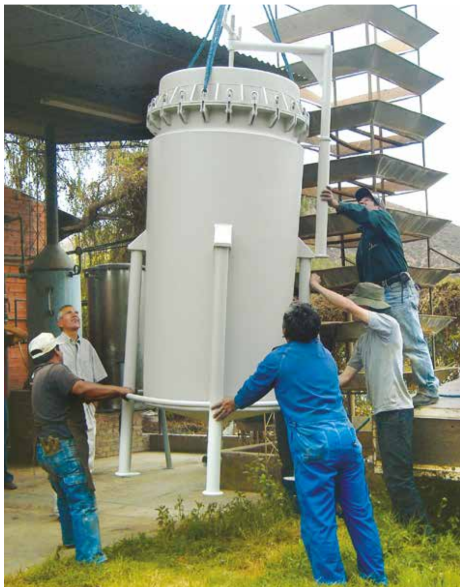
Extractor de aceites esenciales listo para su instalación (acero inoxidable).
